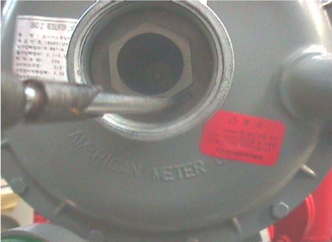
그림12 : 조절기 Body 부분의 Cap을 열고 -자 드라이버로 압력계 ⑦을 보면서 설정 압력까지 스프링을 조여 준다.
