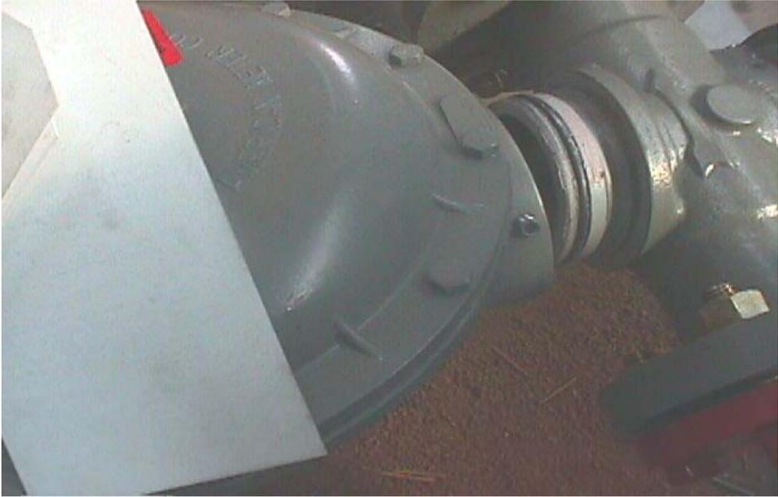
그림2 : Body부 압력조절 부분과 Head 유량조절 부분이 분리되는 그림
